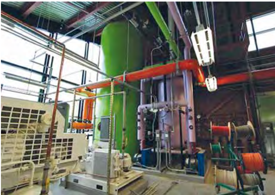
Resim C: Genişleme tankı (yeşil) ve yedek su tankı (mor).
