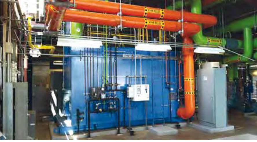
Resim A: Yeni HTHW jeneratörü
