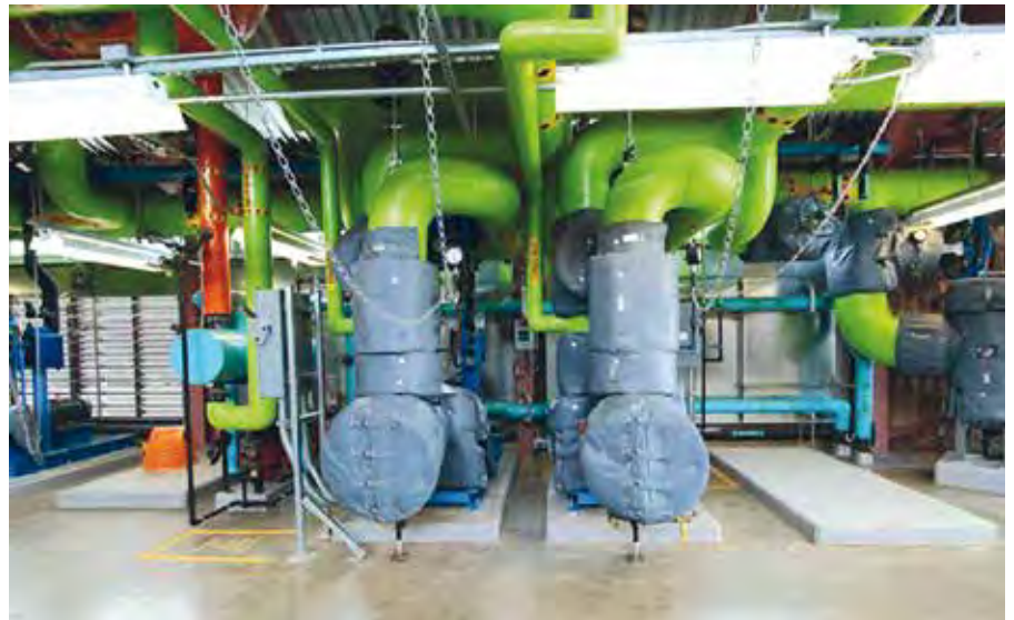
Resim B: Birincil Devre HTHW Pompaları
